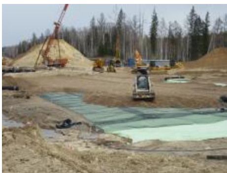
Рис. 7. Устройство гибкого ростверка
