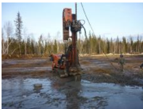
Рис. 5. Производство работ по технологии струйной цементации грунтов
