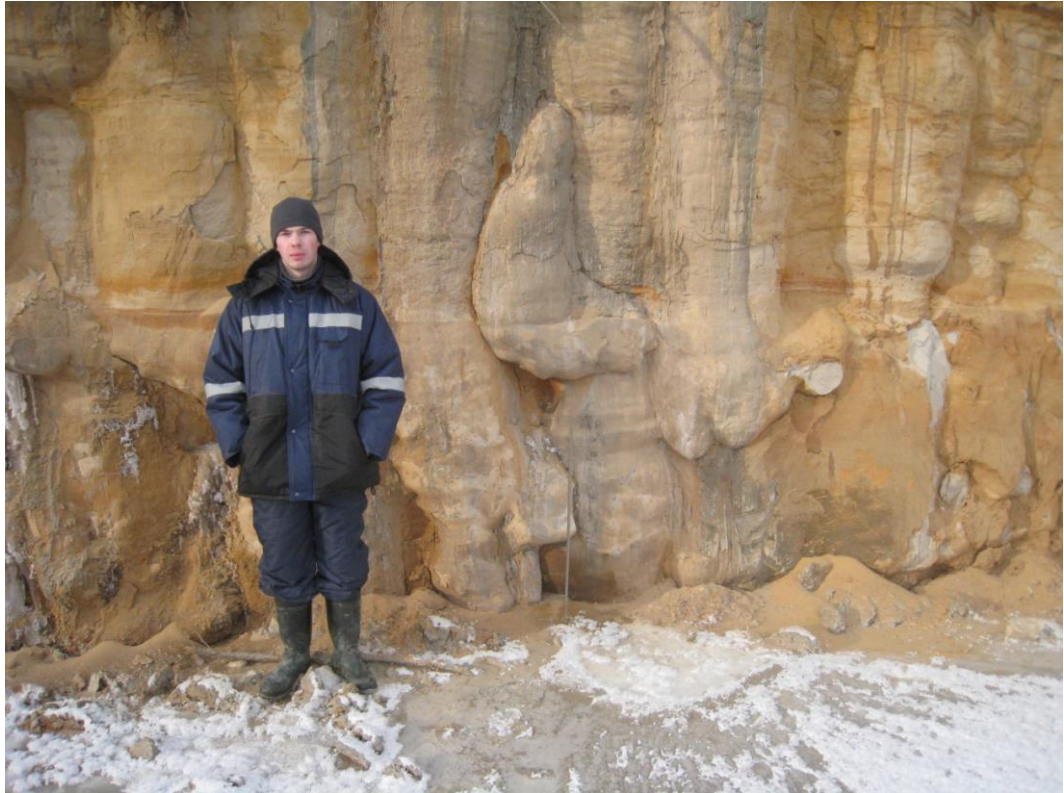
Рис.7. Внешний вид участка с ликвидированным дефектом сплошности ограждения.
