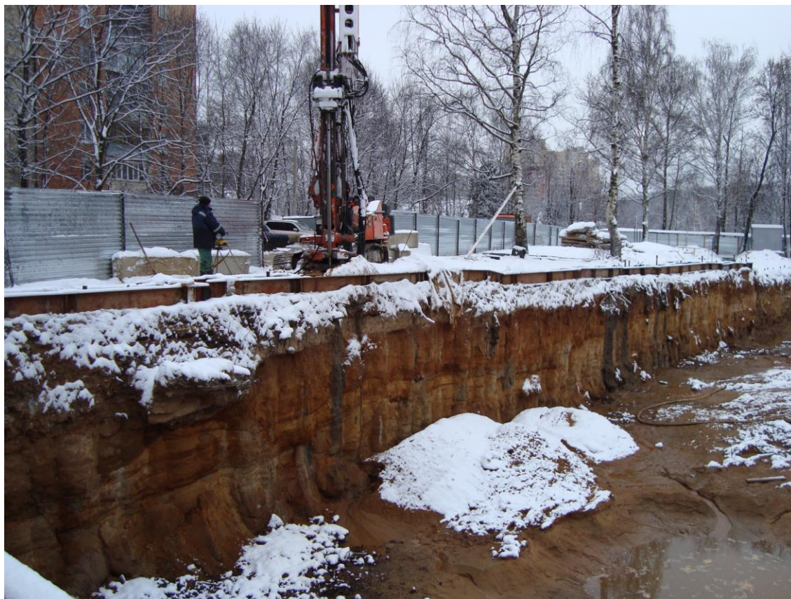
Рис. 6. Устройство свай-дублеров.
